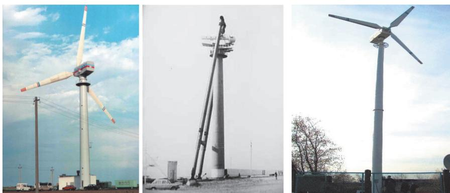
Рис. 9. Ветроустановки МКБ «Радуга» мощностью 1000 кВт, Калмыцкая ВЭС (июнь 1995 г.) и ее монтаж с помощью «шевра» 16 кВт (полигон в Дубне)
