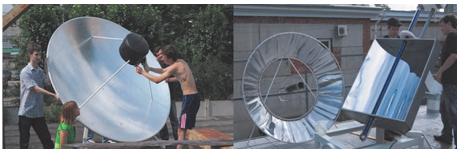
Рис. 5. Монтаж солнечных концентраторов
