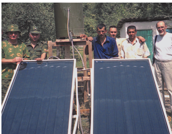
Рис. 25. Наладка системы солнечного ГВС в Таджикистане с использованием солнечных коллекторов Каменск-Уральского металлургического завода
