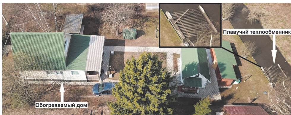
Рис. 2. Вид с воздуха на обогреваемый дом и водоток с теплообменником
